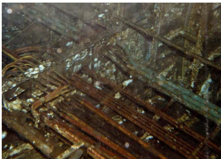
Fußboden mit Rohrleitungen
